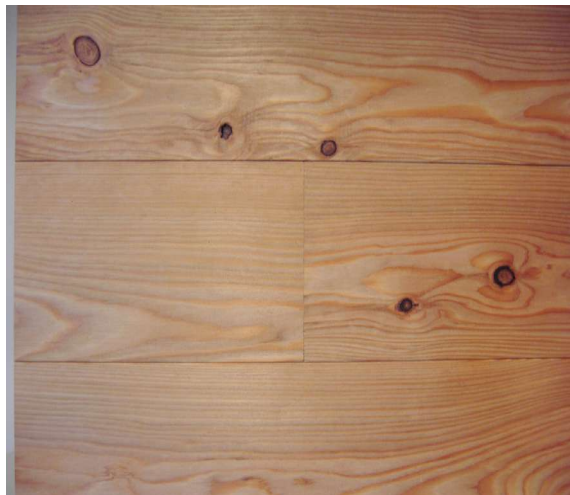
Lärchemassivholzboden endlos verlegt
