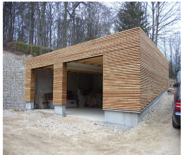
Fassade Garage Nördlingen
