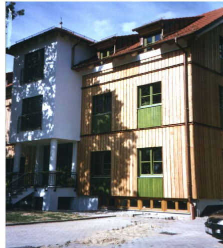
Fassade Eichethof (ehem. Betonquader)
